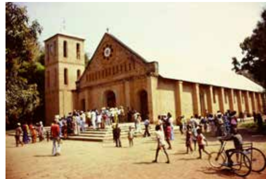
Die Pfarrkirche von Alindao nach der Restaurierung
