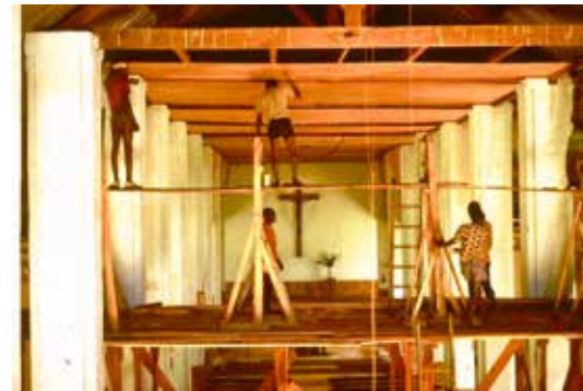
Das Doppelgerüst für den Plafond
