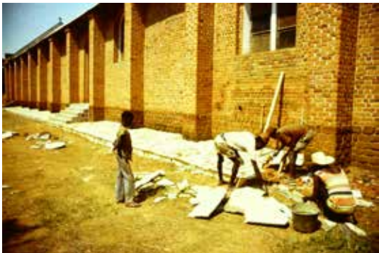
Arbeit an der Seitenmauer: Pflasterung mit Steinen
