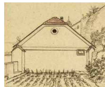
„Früher“ – Dürnstein 7 – vor dem Umbau, undatiert
